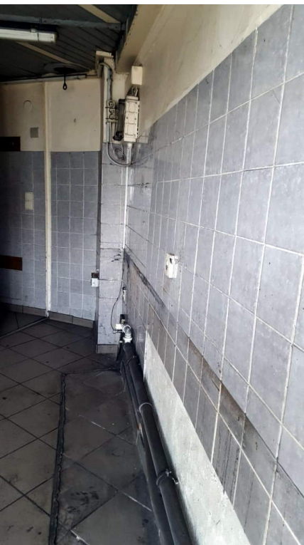
wurden komplett erneuert.
