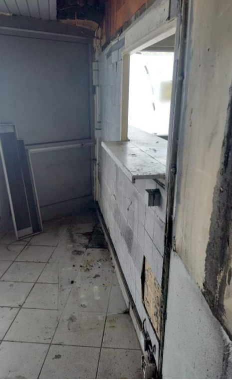
Wände und Leitungen
