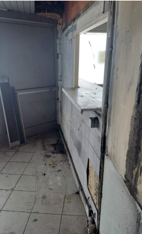
Wände und Leitungen
