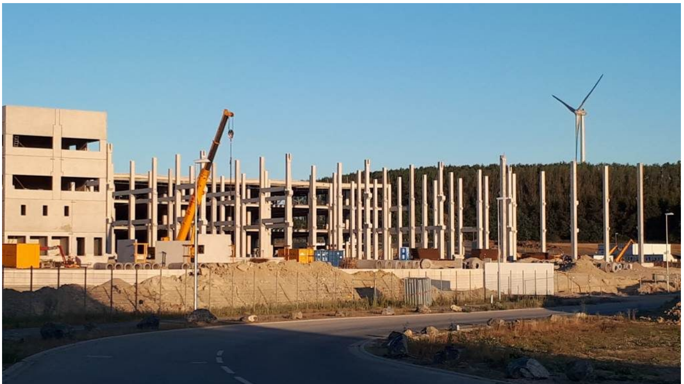
August 2018 Amazon-Bauarbeiten Oelde
