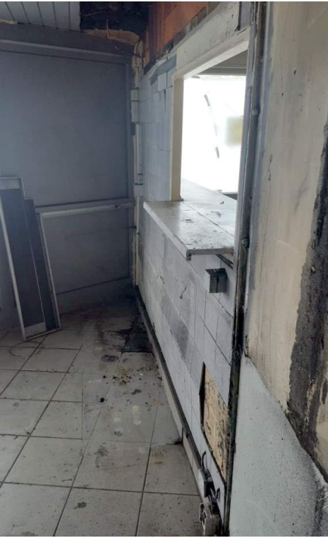
Wände und Leitungen
