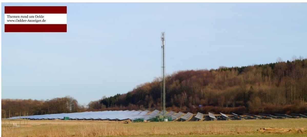
Solaranlage in der Bauernschaft Bergeler
