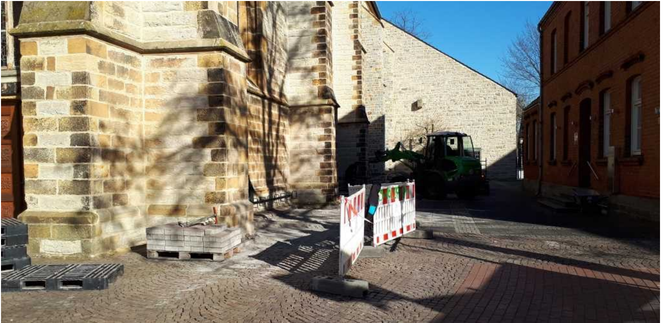
Musterpflasterfläche am 27.02.2019 neu verlegt
