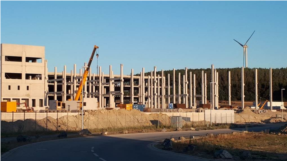
August 2018 Amazon-Bauarbeiten Oelde
