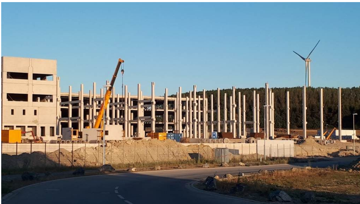
August 2018 Amazon-Bauarbeiten Oelde
