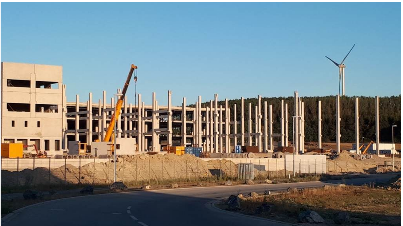
August 2018 Amazon-Bauarbeiten Oelde
